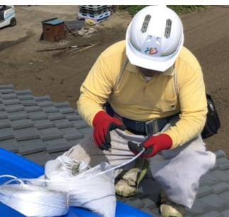
ば、ただブルーシートをかけ、土嚢を置く処置を行います。しかし、組合の仲間はブルーシートをかけるまでの作業が一般とは違います。例えば、雨漏りがしないような場所以の「無事な瓦」と雨漏りしそうな場所の「破損した瓦」を入れ替えること、また、被害箇所を極力一纏めにし、ブルーシートを張る面積を最小限に抑えるなどの工夫も随所でされていきました。屋根工事が本職ではないものの、これまで建設に携わったきた経験が成せるものです。建設職人の技は地元の暮らしの大きな支えとなっています。
