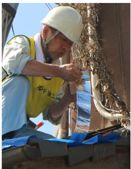
建設職人の発想と技は大きな力です。今回は屋根瓦が飛ばされたり、破損した事による雨漏りを防ぐ処置のブルーシート張りでした。通常であれ
